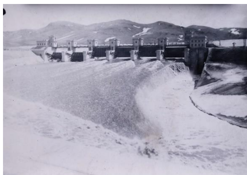
Рисунок 8 - Гидроузел водохранилища 40-е годы
