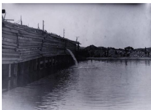
Рисунок 7 - Гидроузел водохранилища 30-е годы
