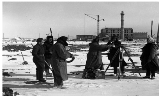
Рисунок 2 - Строительство города Темиртау 60-е годы
